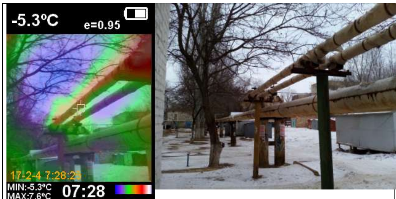
Рис. 3. Участок с качественной изоляцией.
