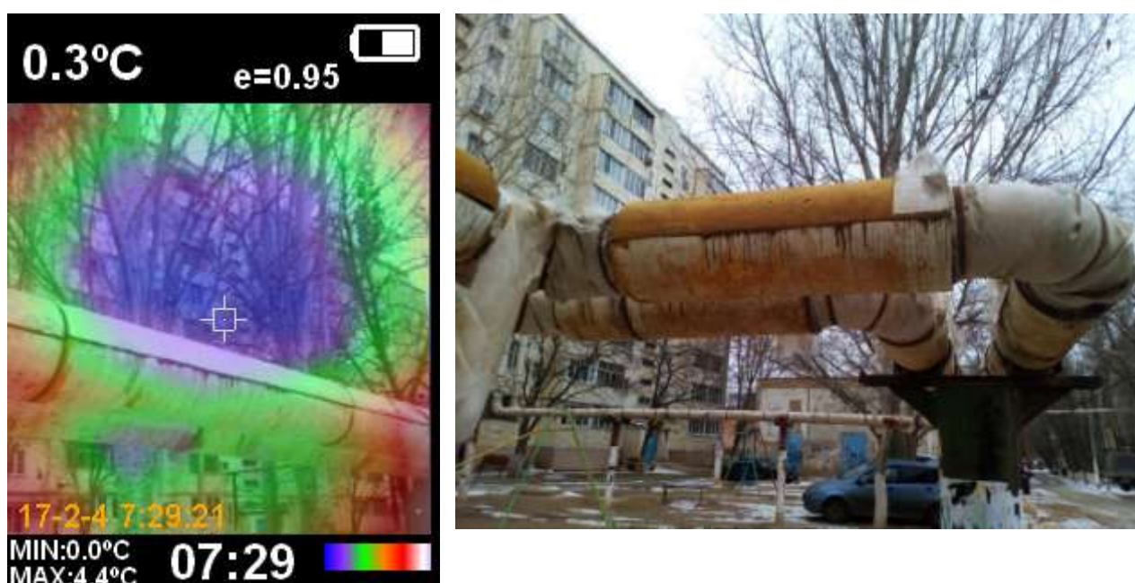
Рис. 4. Участок с качественной изоляцией.
